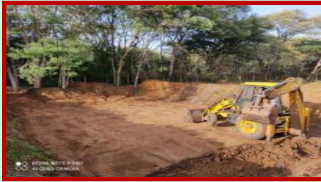
वर्षा जल संचयन ताल/ Rain water harvesting pond
