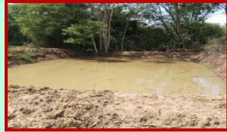
वर्षा जल संचयन ताल/ Rain water harvesting pond
